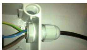
Insérer les Presse-étoupes dans les ouvertures percées. Positionner ensuite les contre-écrous puis les serrer. Enfin, connecter les câbles suivant le plan.
