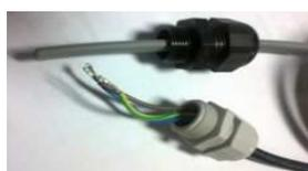
Avant raccordement dans le boîtier, s'assurer que les câbles chauffants et d'alimentation soient préparés et pourvus de leur presse-étoupe respectif.
