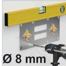
Présenter la platine horizontalement puis percer les huit trous de fixation dans la cloison en veillant à ne pas percer les tubes.
