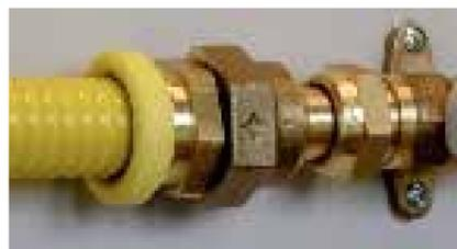
Test d'étanchéité avant de déplier le CLAP
