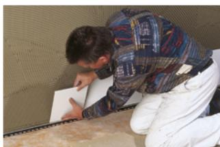
Le polyéthylène n'étant pas stable aux UV à long terme, la natte doit être stockée à l'abri du soleil et recouverte rapidement après la pose.
